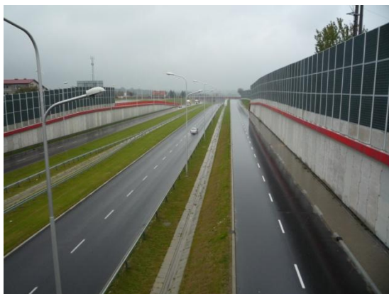
Fot. 3.1 Odcinek drogi dojazdowej poprowadzony w wykopie
