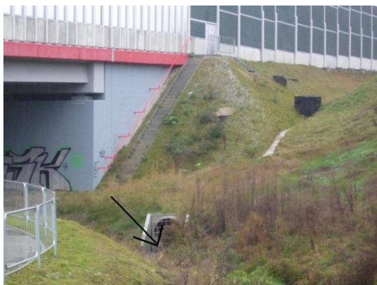
Fot. 5.1 Wylot nr 1 w km 7+590 rzeki Czechówki
