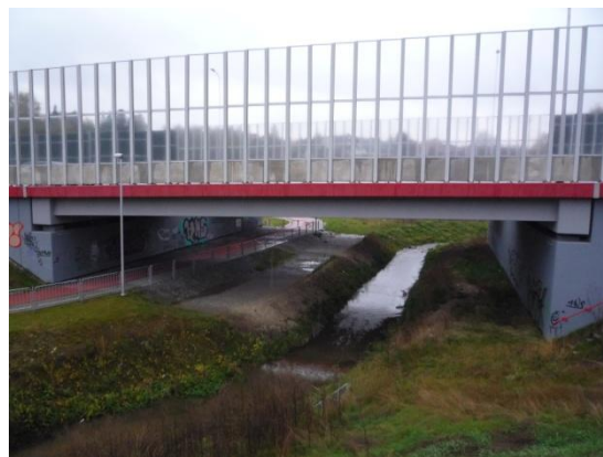
Fot. 3.2 Obiekt mostowy przez rzekę Czechówka i ciąg pieszo-rowerowy
